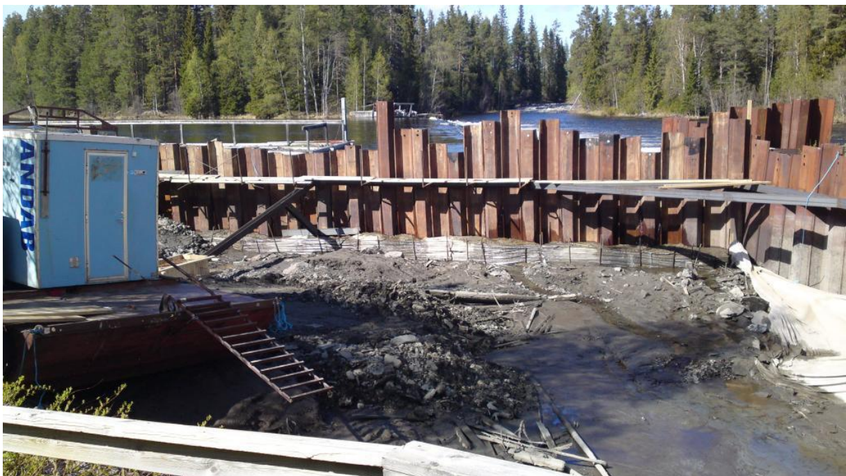
Bild 3 Uppförd fångdamm. Intag torrlagt
