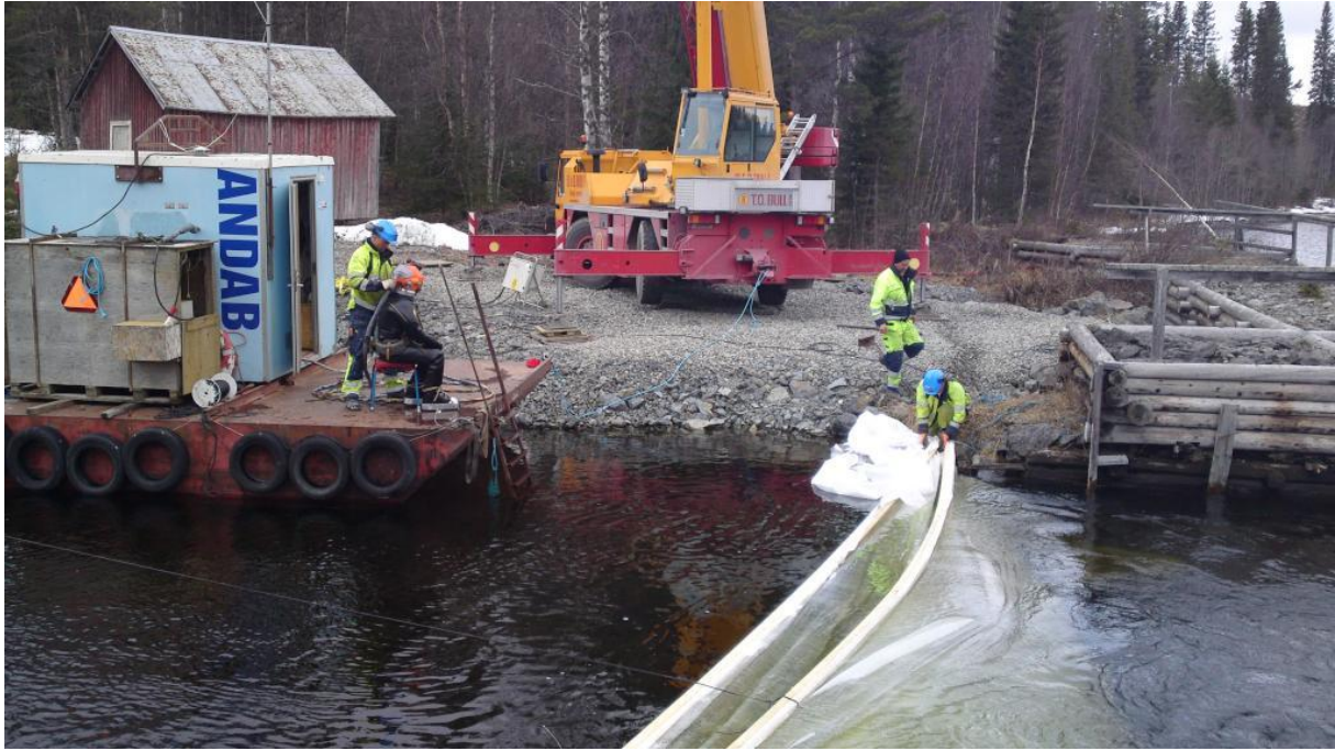
Bild 4 Textildukarna monteras
