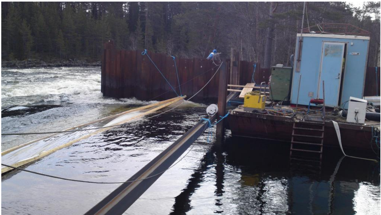
Bild 1 Påbörjad spontning vid vänster anslutning.
