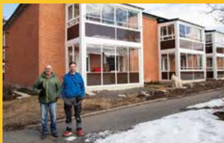
Bengt Mohlin & Håkan Lindberg, styrelsemedlemmar i BRF Östersundshus 22 respektive 18 ser fram emot att arbetet med de nya fjärrvärmeledningarna snart ska dra igång.
