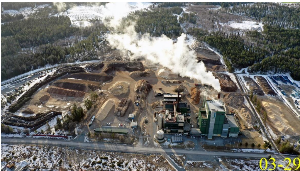
Figur 11. Översiktsbild över anläggningen med tillhörande bränslelagring.
