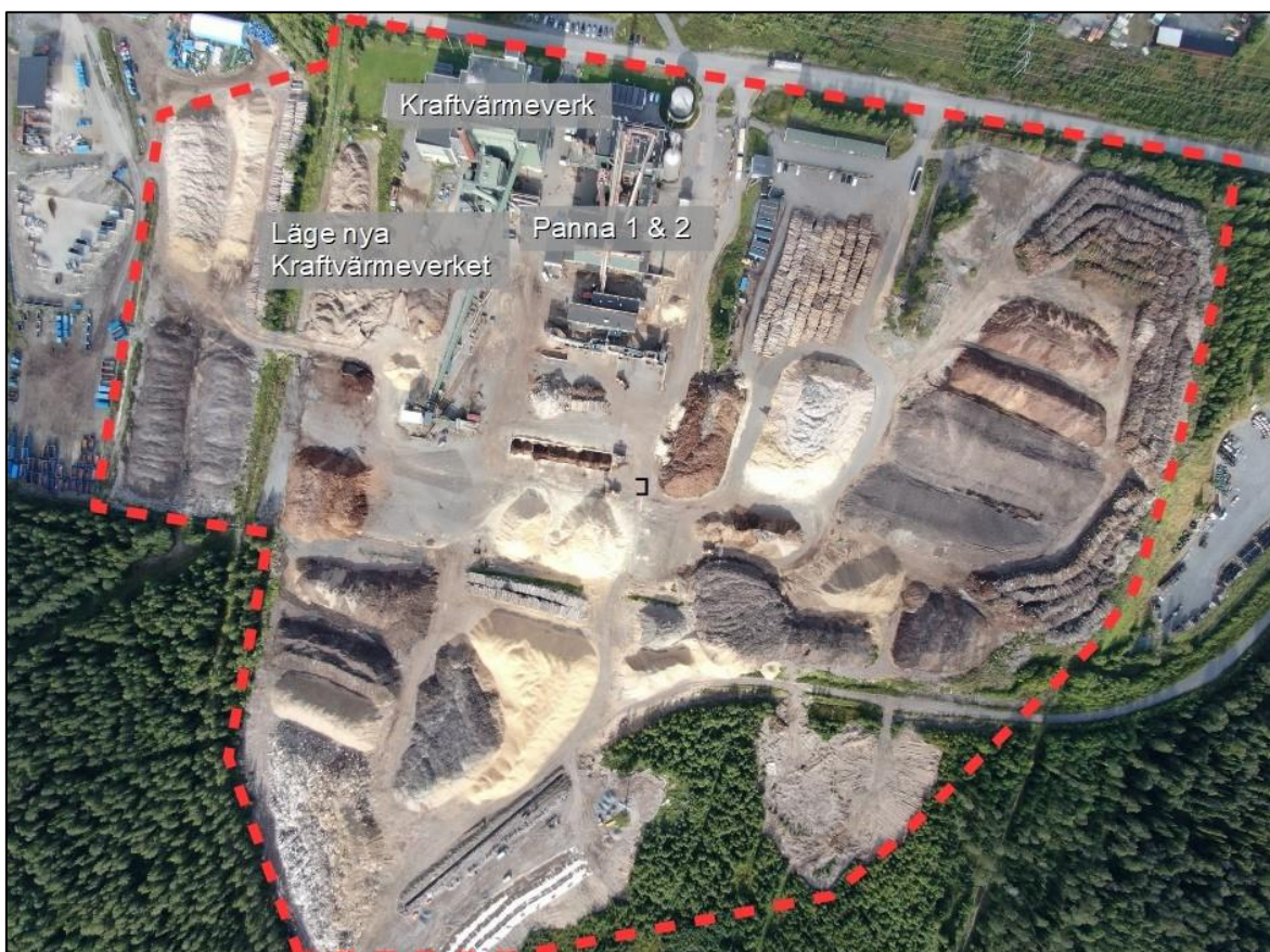
Figur 2. Flygbild över Lugnviksverkets nuvarande område med bränsleplaner och pannanläggningar. Läget för det nya kraftvärmeverket kommer att vara strax söder om nuvarande kraftvärmeverk.
