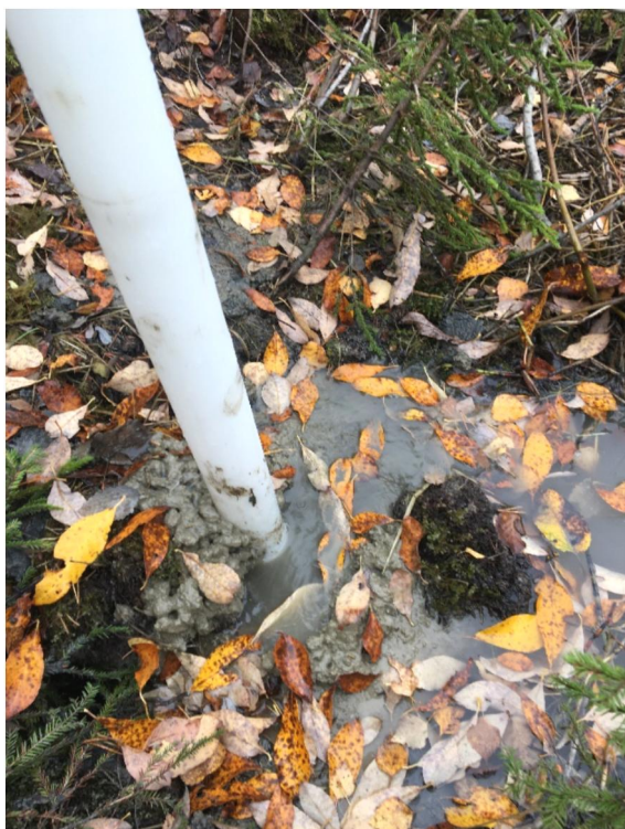
Figur 5. Grundvatten som tränger upp vid rör SW2025. Foto: Sweco
