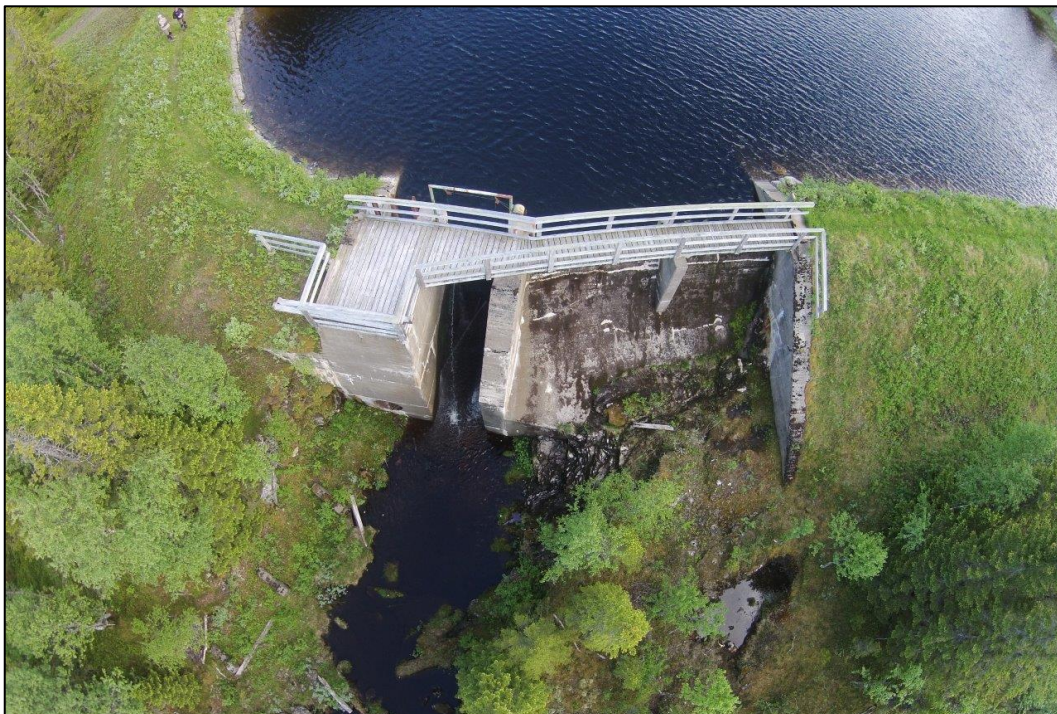
Figur 4. Bilden visar utskovsdelen, de båda ytvattenutskoven till höger. I botten av den vänstra delen av dammen framgår det cirkulära utloppet till en äldre tub för överledning av vatten till ett äldre kraftverk.
