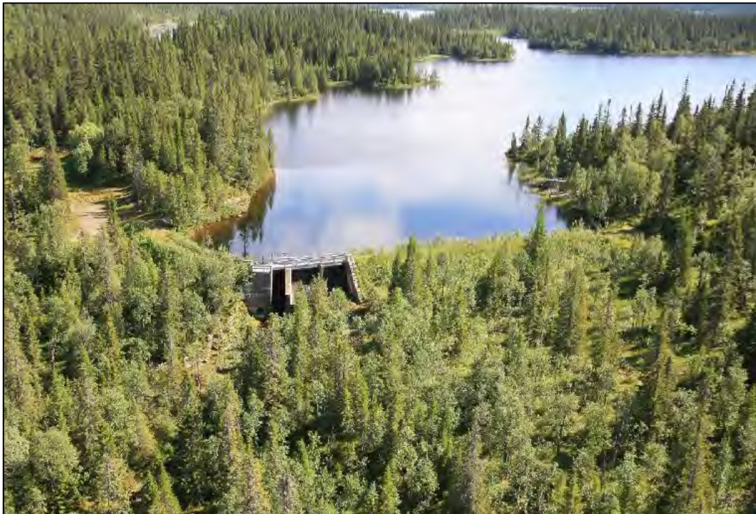
Flygbilden visar Greningen Nedre med dess damm. Fotot taget i riktning mot söder.
