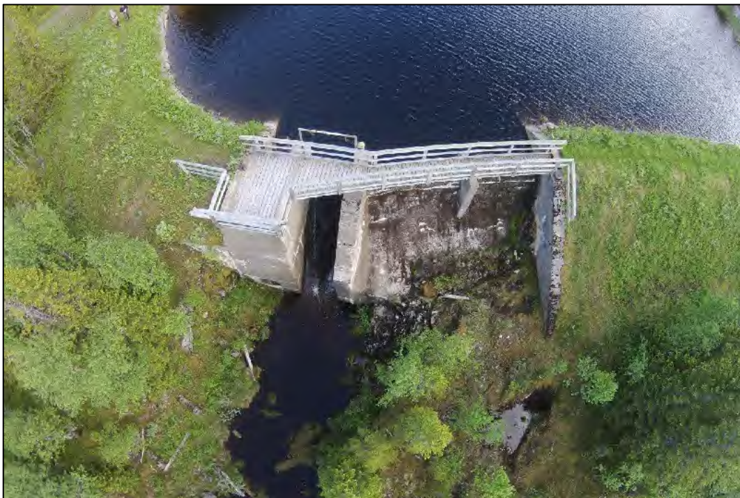
Figur 4. Bilden visar utskovsdelen, de båda ytvattenutskoven till höger.
