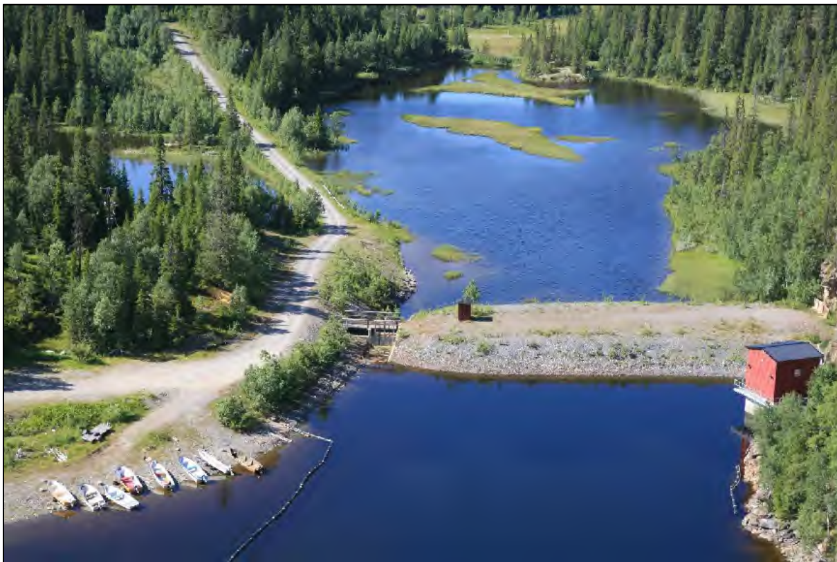
Figur 7. Flygbilden visar dammen mellan Greningen övre och Greningen Nedre. Greningen Övre i förgrunden. Intagshuset till Duveds kraftstation till höger i bilden.
