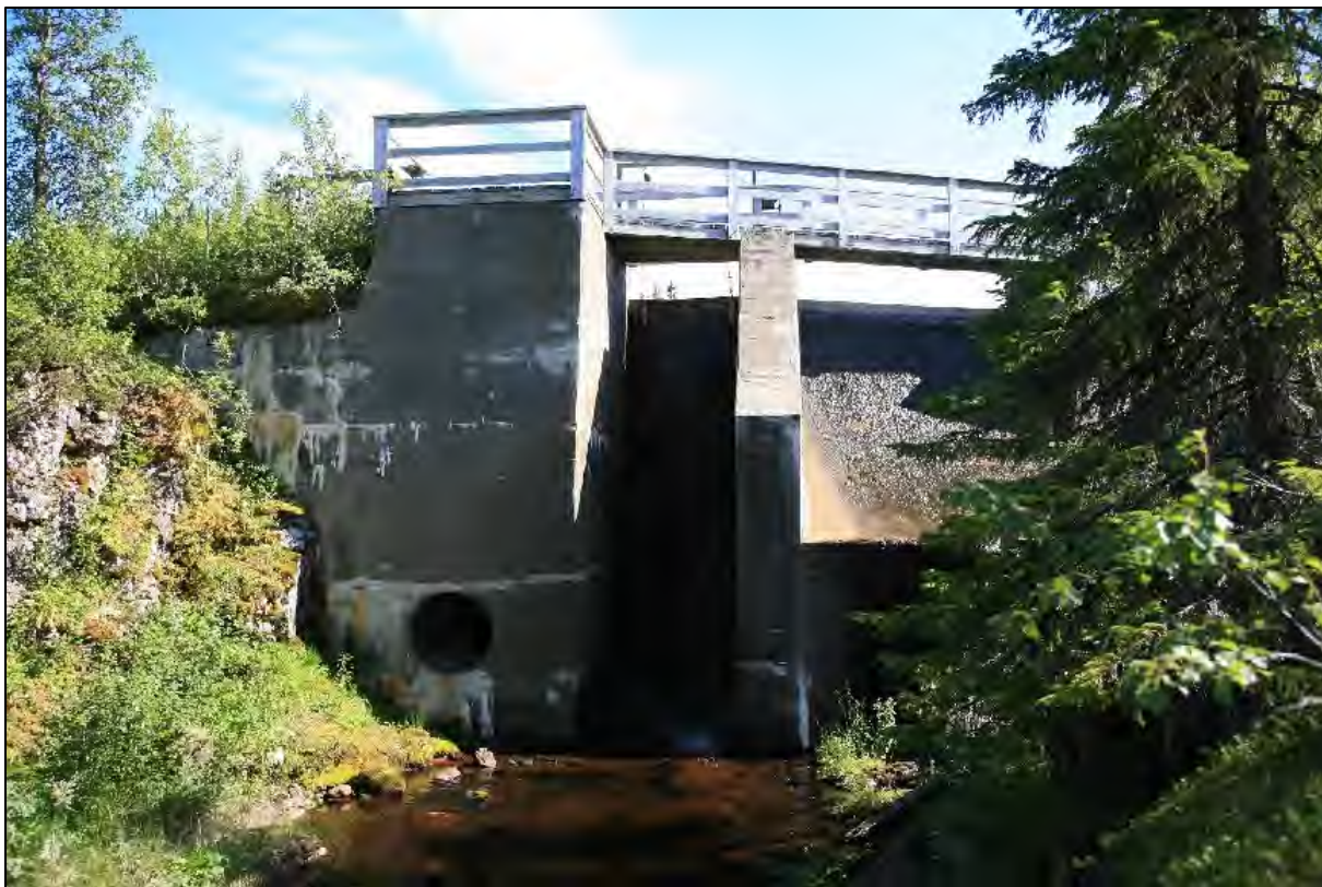
Figur 6. Fotot visar utskovet från nedströmssidan.
