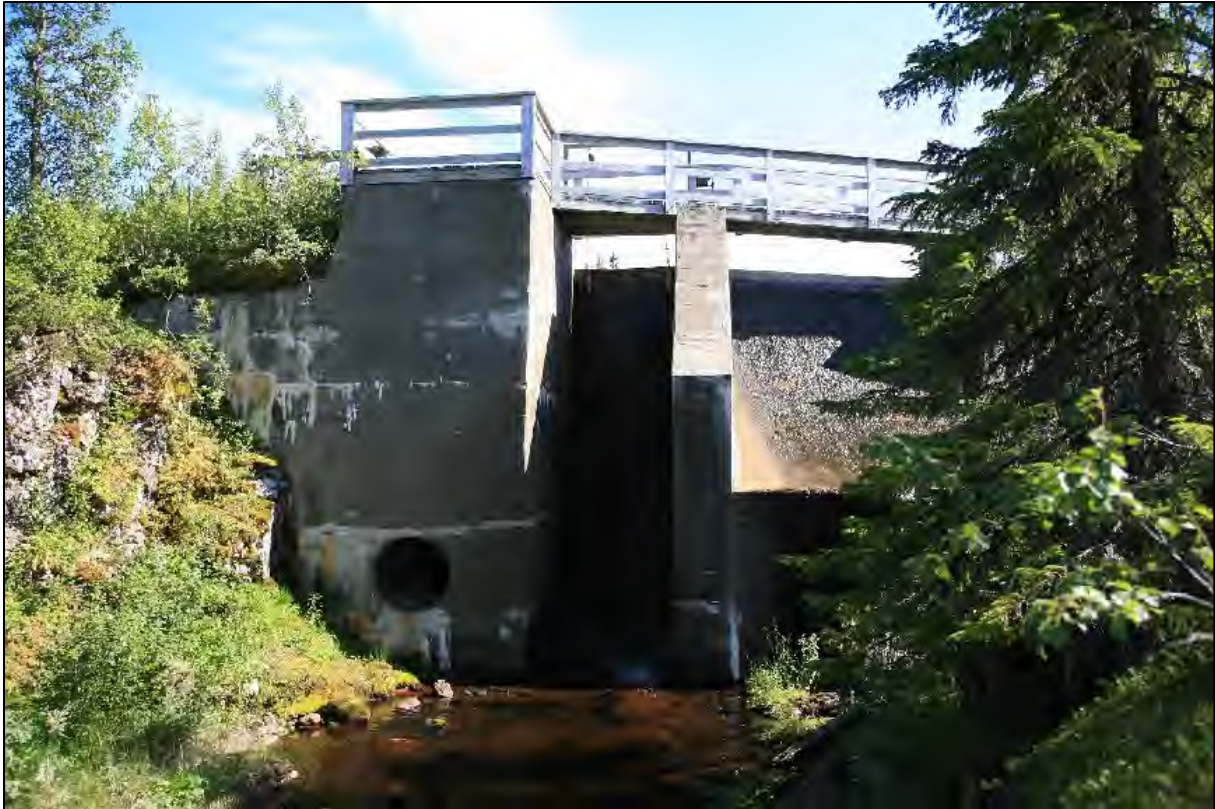
Figur 6. Fotot visar utskovet från nedströmssidan.
