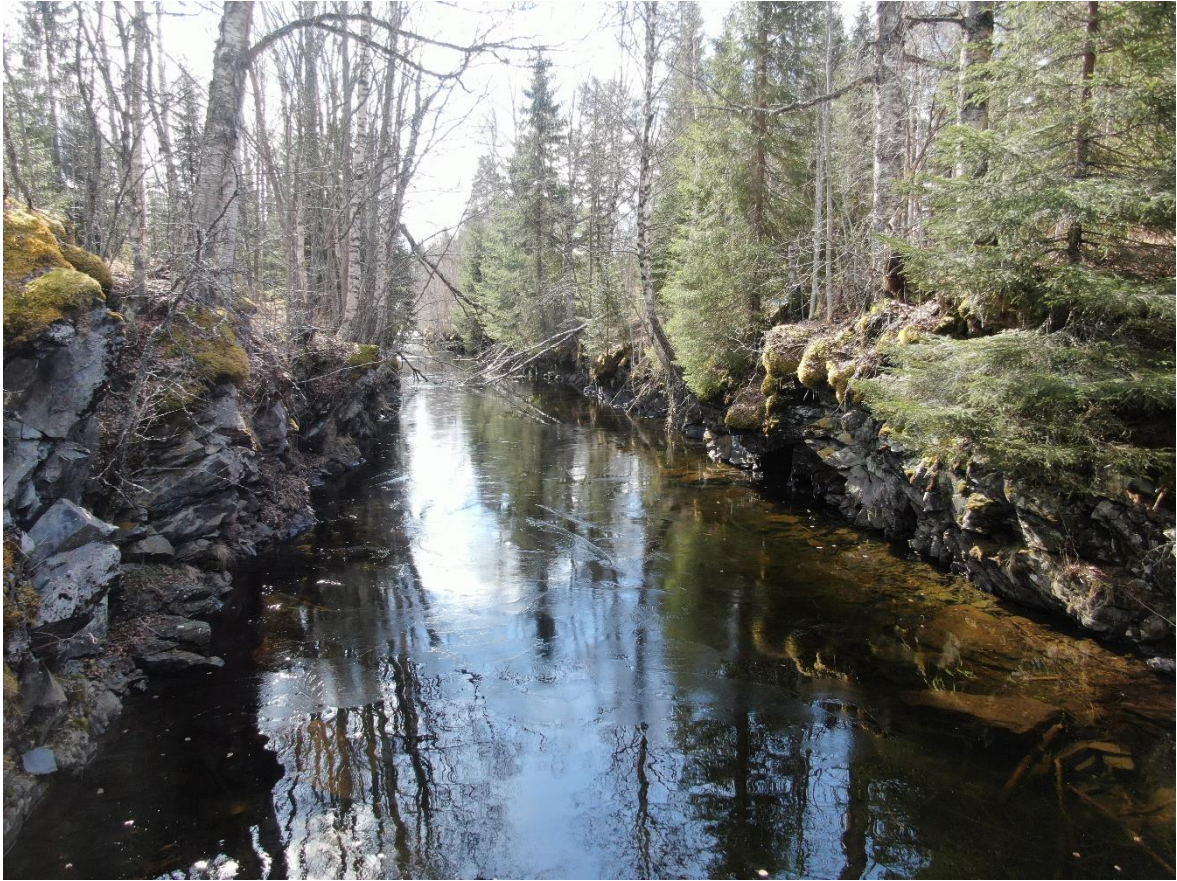
Figur 20. Utloppskanalen, Lången skymtar i slutet.
