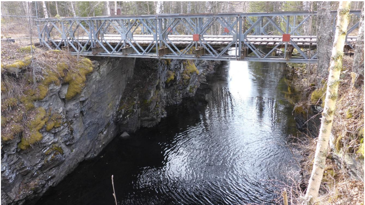
Figur 19. Bro nedströms kraftstationen. Kanalens sidor är på bilden fyra meter höga, bredden är 9 meter.
