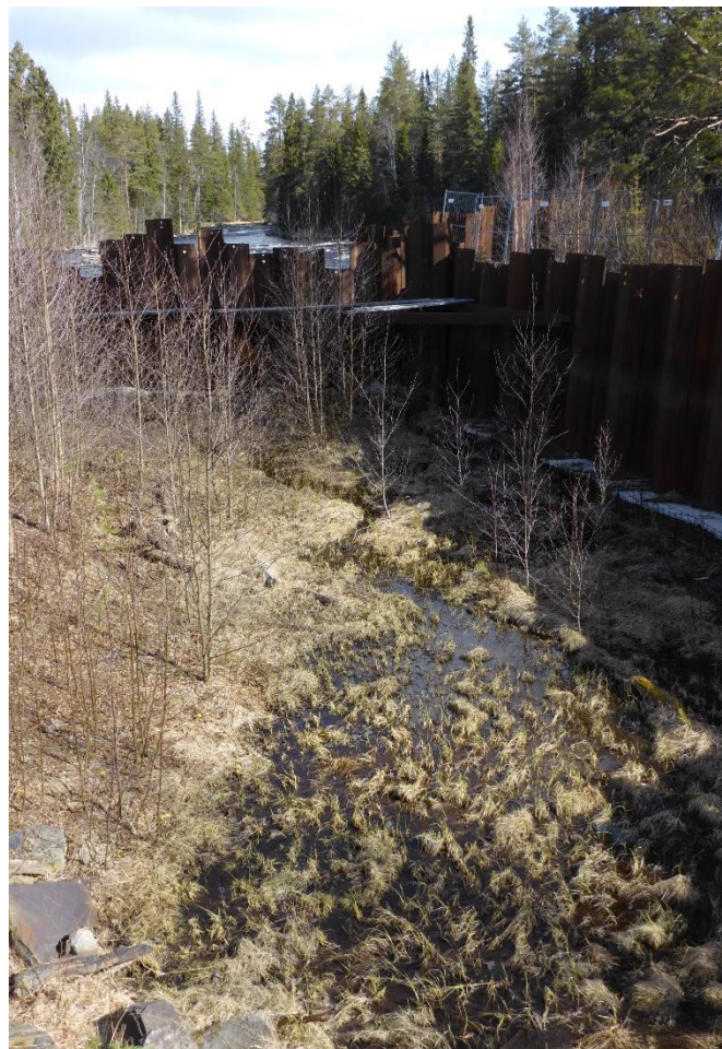
Figur 14. Fotot är taget från kraftstationen och visar intagskanalen i riktning mot larsensponten och Långan.
