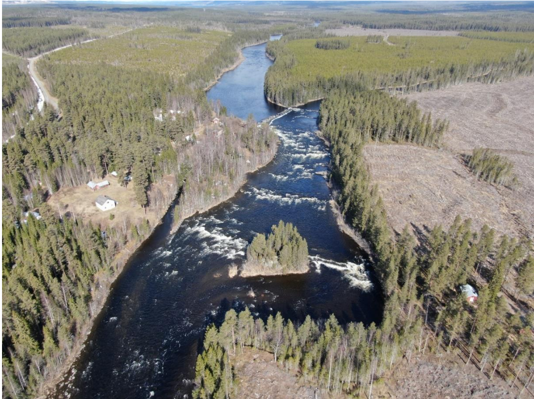
Figur 2. Flygfotot visar Långforsen med kraftverket och överfallsdammen strax ovanför mitten av fotot.
