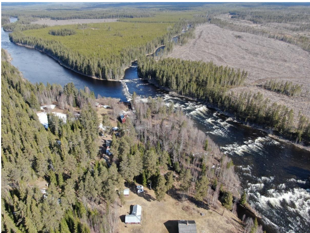
Figur 3. Strax över mitten på flygfotot är överfallsdammen och kraftstationen synliga. Till vänster om kraftstationen och i förgrunden syns ett flertal kringbyggnader såsom förråd, garage och maskinistbostad. Samtliga byggnader kommer att rivas.
