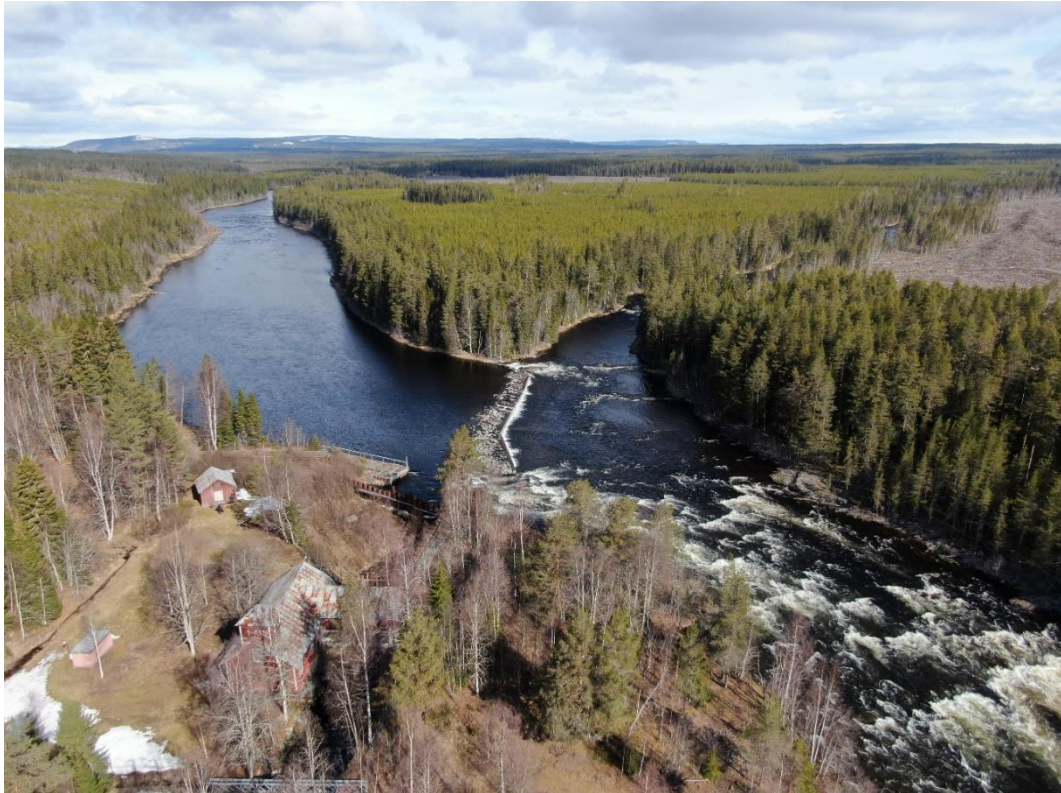
Figur 4. Flygfotot visar Långan med kraftverket och överfallsdammen i mitten av fotot. Till vänster om kraftstationen syns en förrådsbyggnad och söder därom en transformatorbyggnad.
