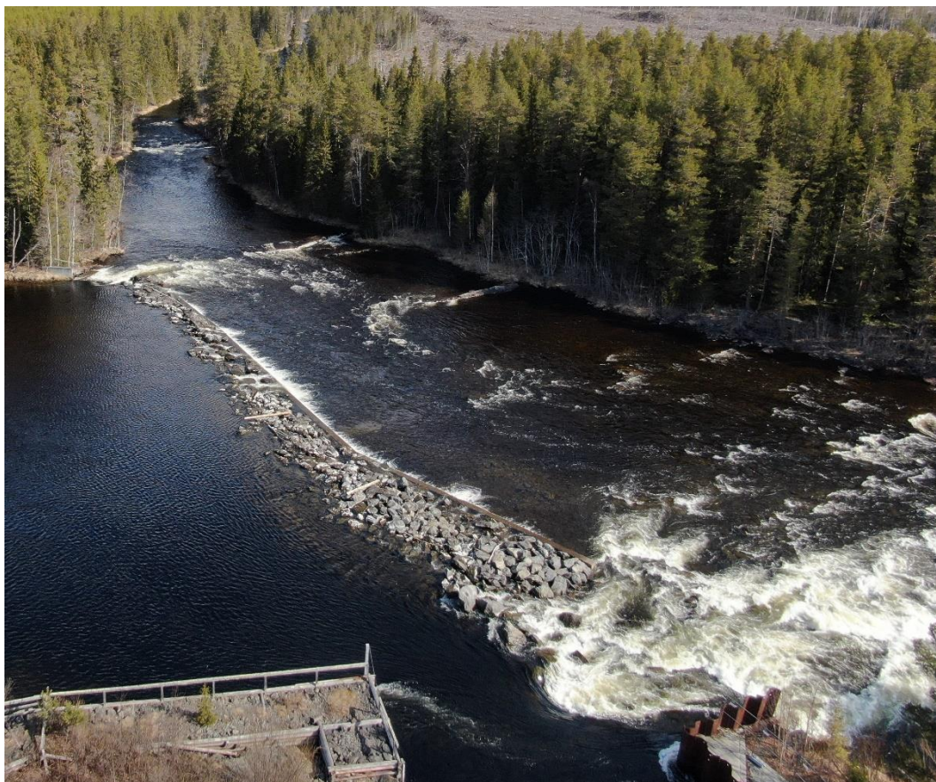
Figur 9. Bilden visar överfallsdammen. Till höger Lången, uppåt i bild syns Gysån. Rivningen är tänkt att börja från vänster sida (högst upp i bilden) Överfallsdammen rivs successivt mot höger sida. Rivningsmaterialet återanvänds vid intagskanalen som fyllnadsmassor och erosionsskydd. Utläggning av natursten från konstruktionen kommer att ske i vattendraget för att skapa en så naturlig forssträcka som möjligt.
