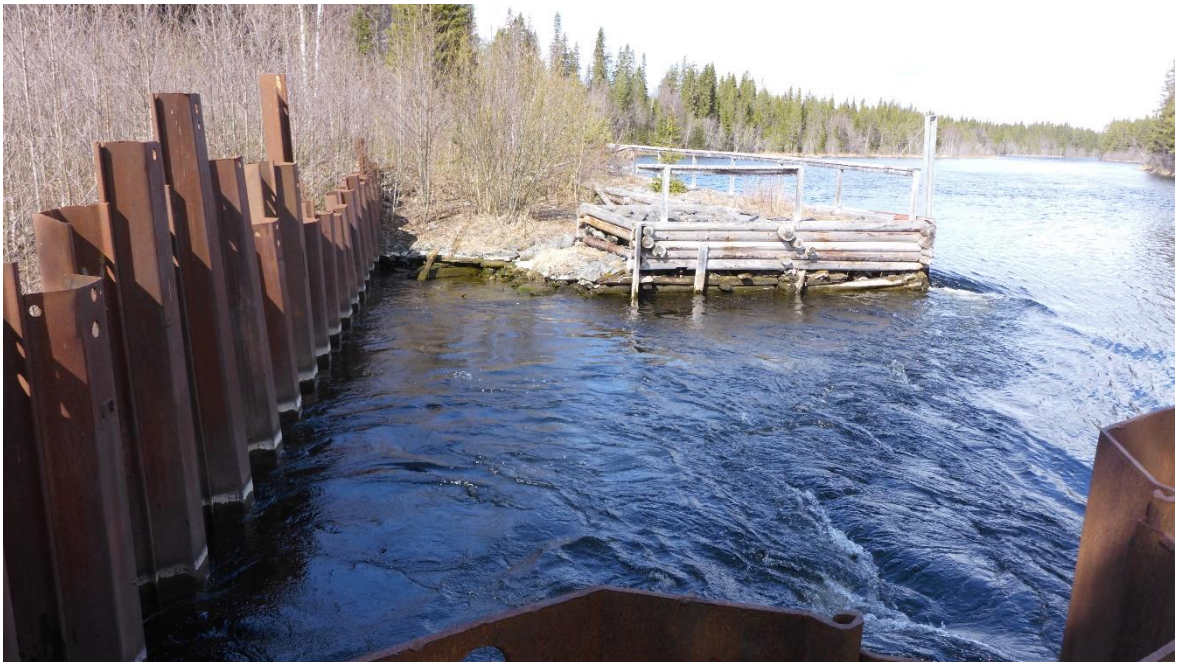
Figur 12. Fotot är taget från kröndammen och visar till vänster den larsenspont som dämmer intagskanalen. I mitten syns en stenkista från timmerflotningen på Långan.
