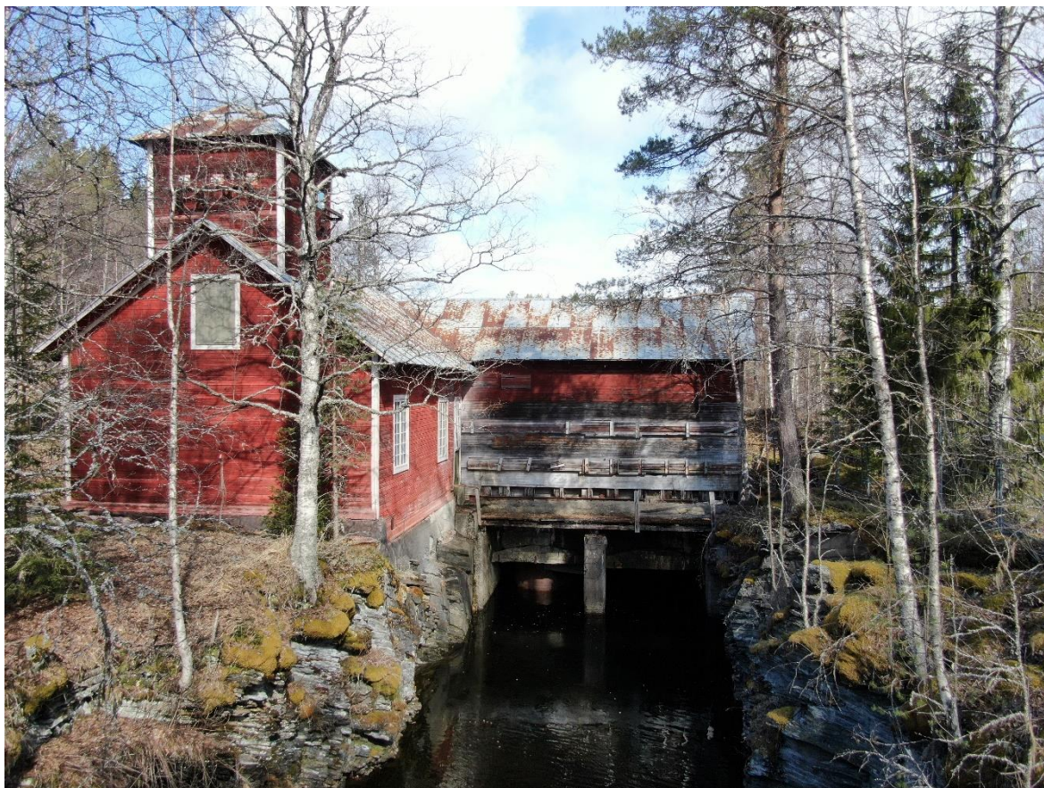
Figur 17. Fotot visar utloppet från kraftstationen till utloppskanalen.
