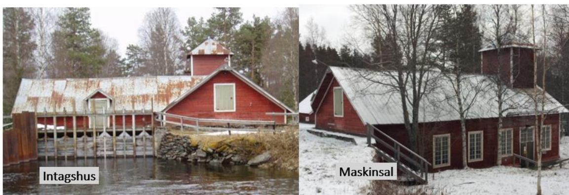
Figur 11. Fotona visar intagshuset och maskinsalen som kommer att rivas.
