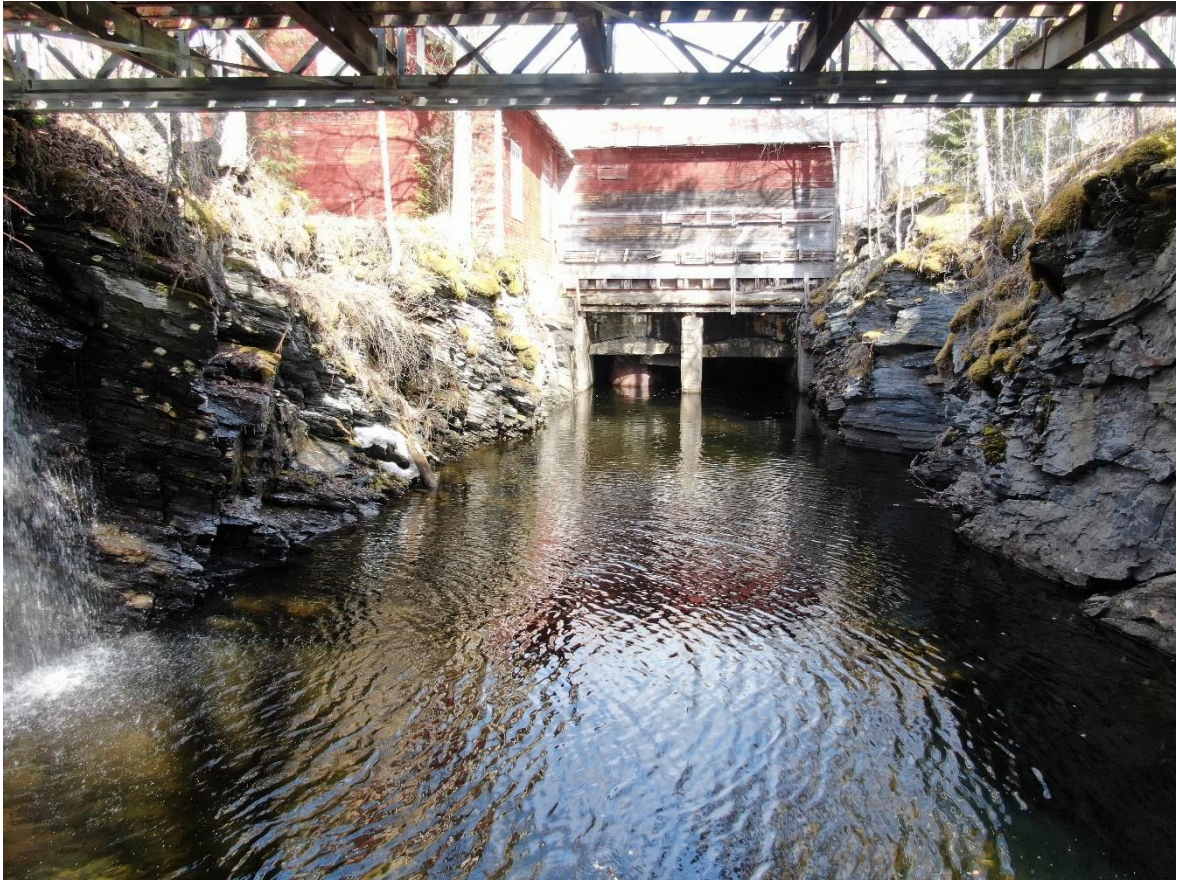
Figur 18. Utlopp från kraftstationen till utloppskanalen. Kanalens sidor är på bilden fyra meter höga, bredden är 9 meter.
