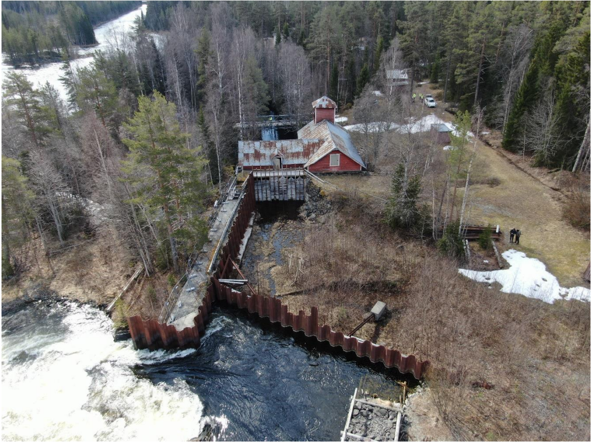
Figur 11. Fotot visar intagskanalen och kröndammen med dess larsenspont. I slutet av intagskanalen finns kraftstationen med dess intagsluckor.
