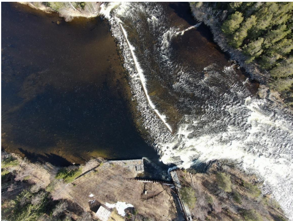
Figur 7. Flygfotot visar överfallsdammen med intagskanalen längst ned i bilden.
