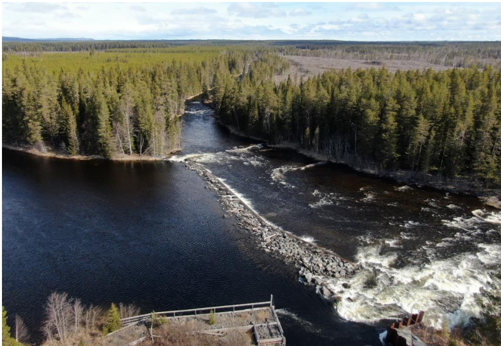
Figur 6. Flygfotot visar överfallsdammen som har till funktion att hålla vattenytan höjd och därmed skapa goda förutsättningar för vattenavledning till kraftverkets intagskanal. Det finns två raserade partier i den vänstra och högra delen av överfallsdammen, Längst ned i bilden syns en stenkista som är en flottningsrest.
