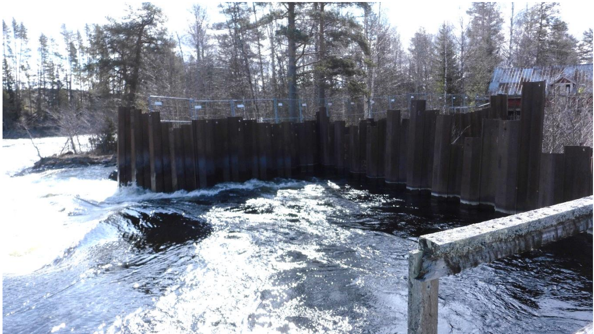
Figur 13. Fotot är taget från stenkistan och visar larsensponten, där den vänstra halvan är en förstärkning av kröndammen och den högra fungerar som dämme av intagskanalen.
