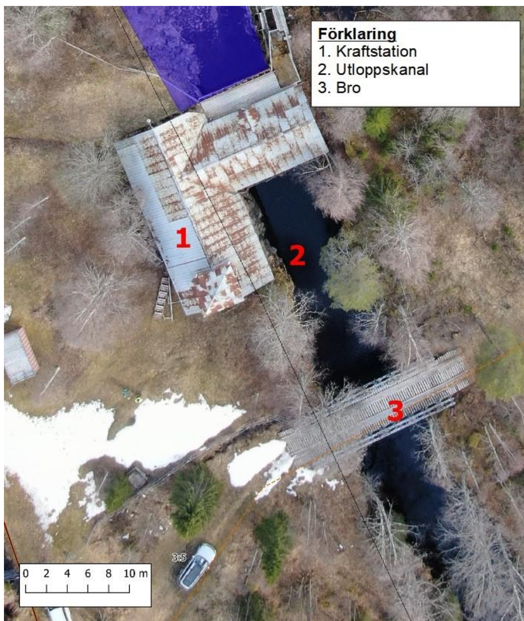
Figur 12. Fotona visar kraftstationen, utloppskanalen och den nedanför liggande bron.
