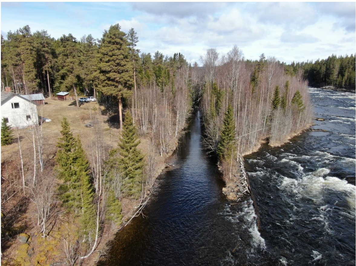
Figur 21. Uppströmsvy som visar utloppskanalen.
