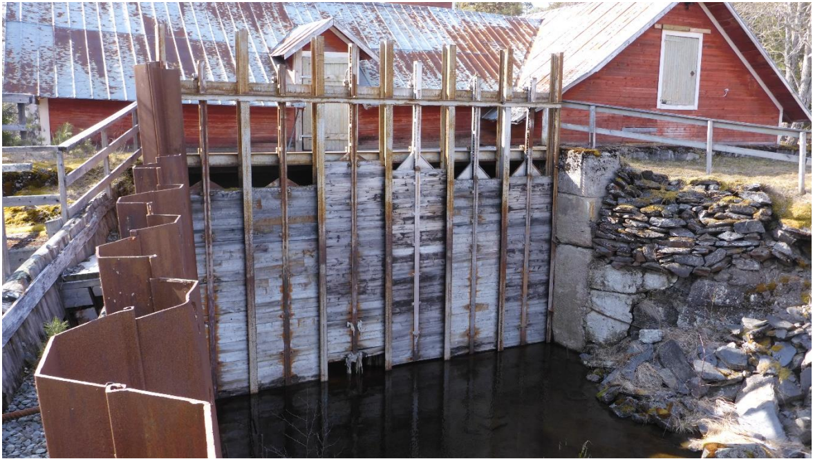
Figur 15. Fotot visar intagsluckorna. Foto från kröndammen.
