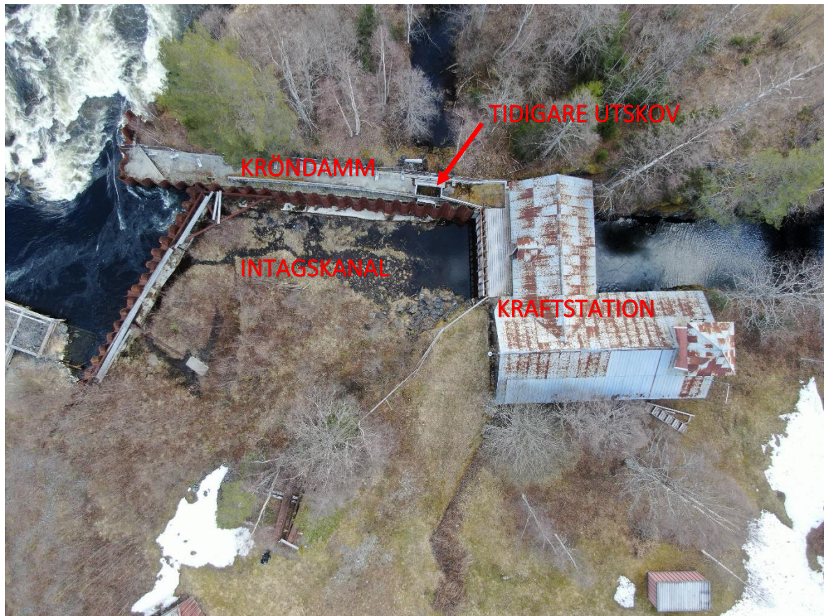
Figur 10. Fotot visar de olika delar av kraftverket. Den torrlagda intagskanalen är synlig mitt i bilden. Mellan intagskanalen och Lången sitter en larsenspont. Kröndammen är förstärkt med en larsenspont mot intagskanalen.
