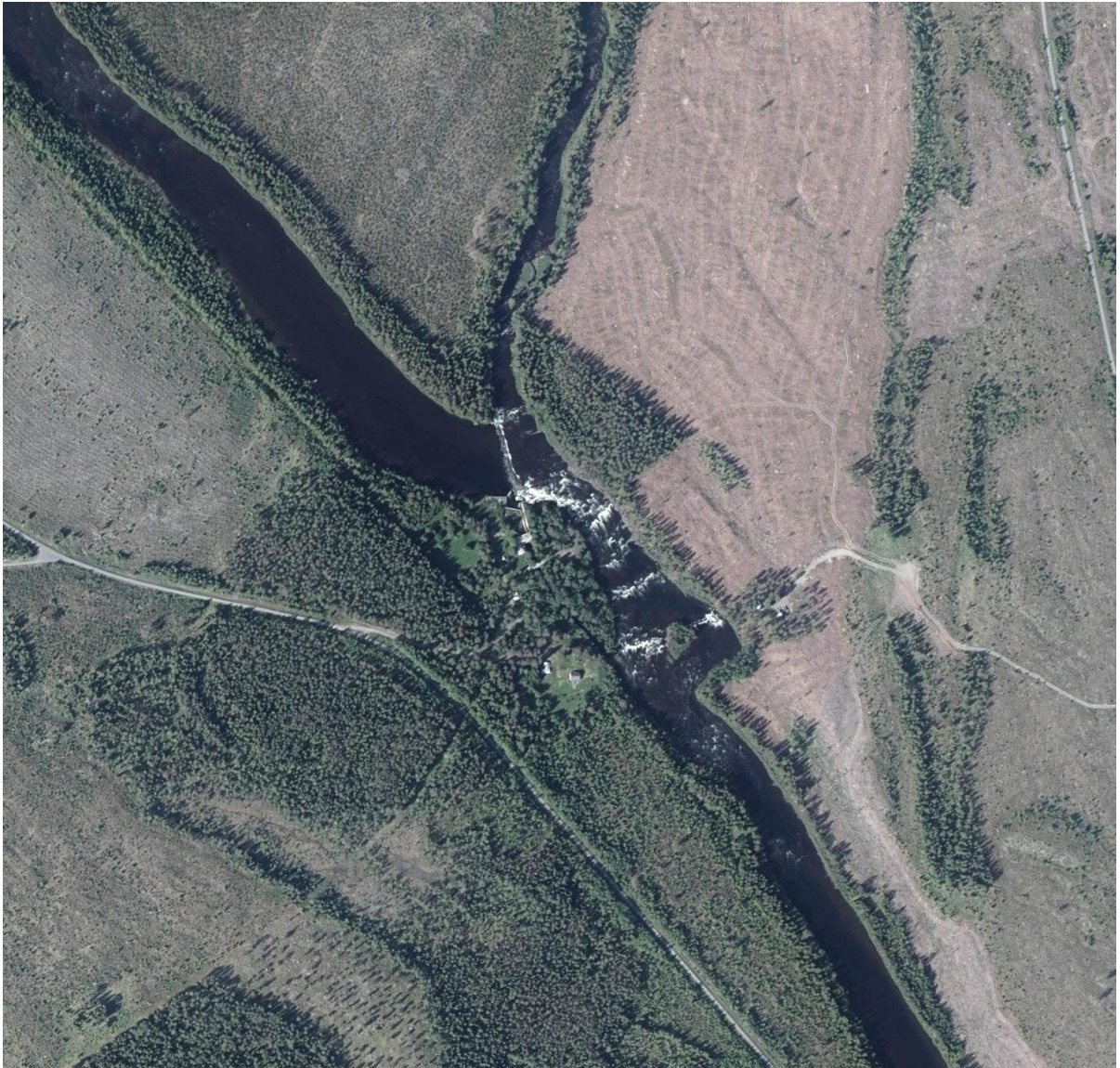
Figur 1. Flygfotot visar Lången med kraftverket och överfallsdammen i mitten av fotot.
