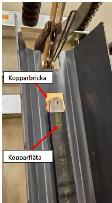
Montage av kopparbricka och kopparfläta samt skyddskåpan på mittfas
