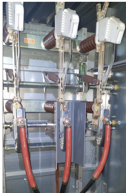
Komplett montage av flexanslutning
