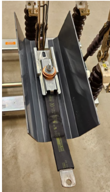
Montage av flexanslutning på mittfas
